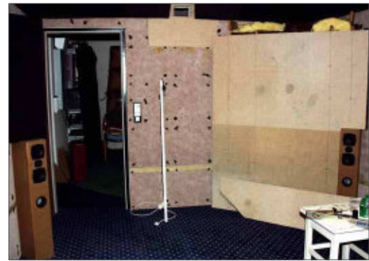
Eine schräge Wand als Bassfalle und Raumgeometrieveränderer
