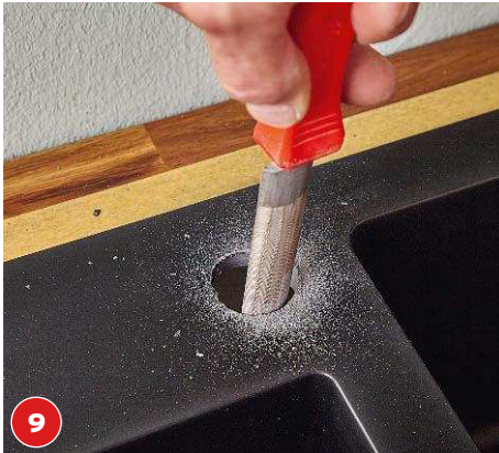
9 Die Bruchkante mit leichten Hammerschlägen vollständig entfernen und mit einer Feile den Rand nachbearbeiten.
