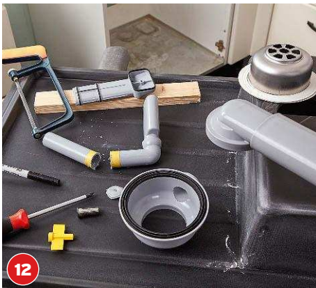
12 Das Siphon und die Abflussrohre für den Abfluss anpassen. Die Abflussrohre, wenn nötig, mit der Feinsäge kürzen.
