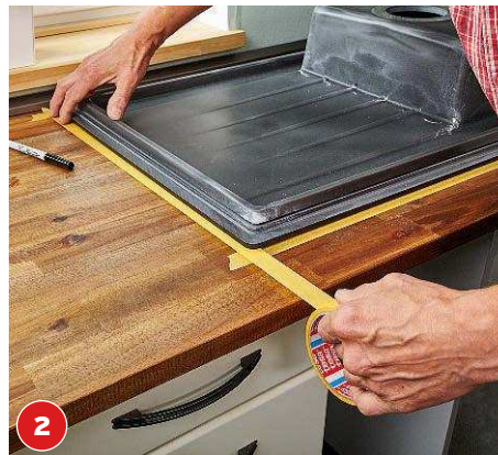
2 Die Spüle sorgsam auf der Arbeitsplatte ausrichten. Den Umriss mit Malerkrepp auf der Arbeitsplatte abkleben.
