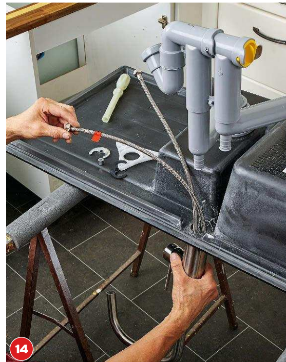
14 Die zwei Wasseranschlussschläuche der Armatur werden durch das Montageloch geführt.
