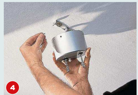
2 Die Dübel Flügel zusammendrücken. Dann den Dübel in das Loch schieben, bis er auseinanderklappt.
