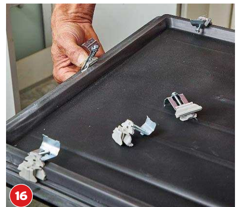
16 Die Befestigungsclips gleichmäßig auf alle Seiten verteilen und in die dafür vorgesehenen Nuten stecken.
