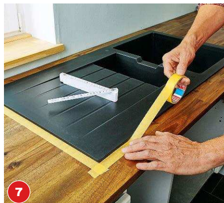
7 Das Klebeband entfernen und die Spüle probeweise in den Ausschnitt legen. Die Spüle mit Klebeband einfassen.
