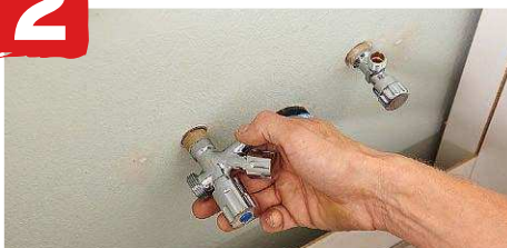
Geräte-Eckventil einbauen
