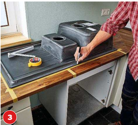
3 Mit einem schwarzen Marker den Umriss der Spüle auf dem Kreppklebeband anzeichnen.
