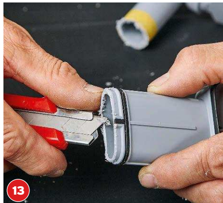
13 Sägegrate mit einem Cuttermesser entfernen. Abflussrohre und Siphon nach Herstellerangaben zusammenbauen.
