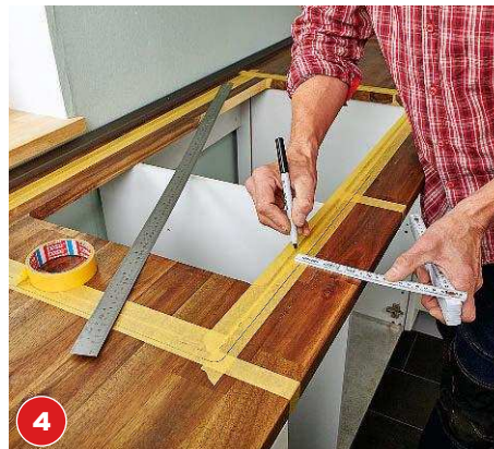
4 Die Kontur an allen Seiten um 10-12 mm (siehe Herstellerangaben) nach innen versetzen – das ergibt den Ausschnitt.
