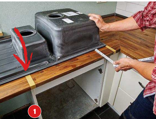
1 Die Seitenwände auf der Arbeitsplatte markieren. Die Spüle dazwischenlegen. Auf Anschlüsse und Ablauf achten!
