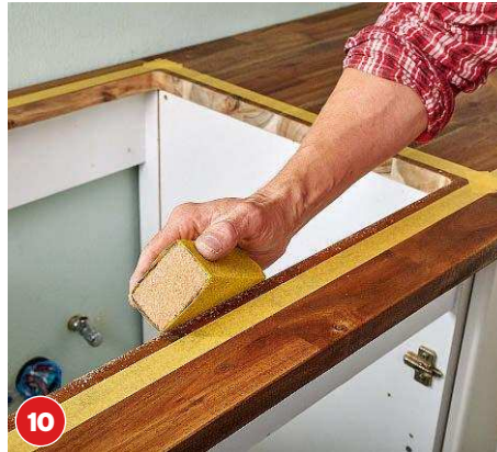
10 Die Spüle herausheben und die Sägekante der Arbeitsplatte mit einem Schleifklotz (120er-Körnung) brechen.
