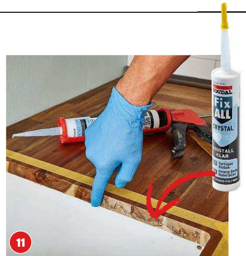
11 Die Kante mit Polymer-Dichtstoff versiegeln: Dichtstoff auf die Kante geben und sorgfältig rundherum verteilen.
